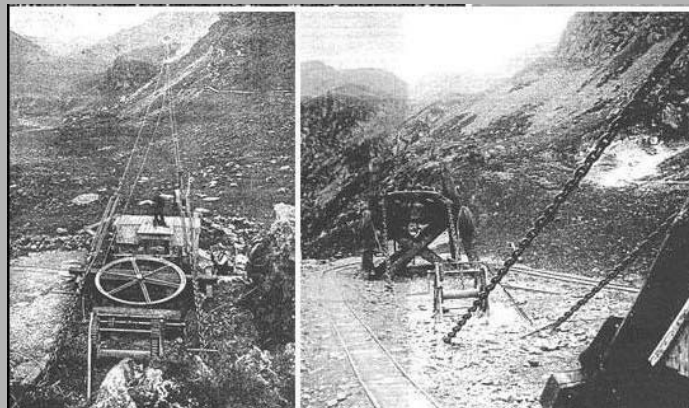
Système bicâble pour le transport du minerai Station intermédiaire
