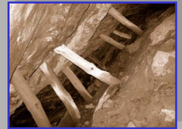
Étayage du chantier au niveau 1.
