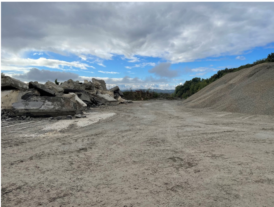
Photo 3 : Des blocs de béton récupérés (à gauche) au granulats (à droite)
