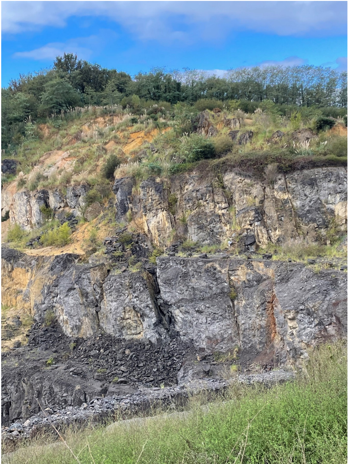
Photo 4 : Fracturation est-ouest des calcaires urgoniens en front de carrière
