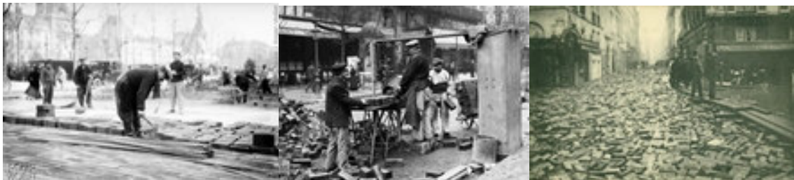
Pavage en bois. Pose de baguettes © J. Boyer/ Roger-Viollet 1908 // Machine à retailer les pavés © J. Boyer/ Roger-Viollet 1908 // Pavés flottants lors de la crue de la Seine © BHVP/ Roger-Viollet, 1910
