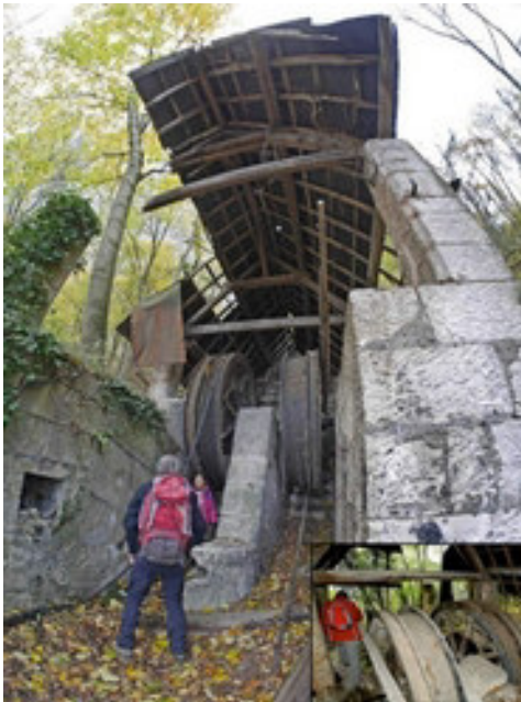
Restes d'installations de surface
