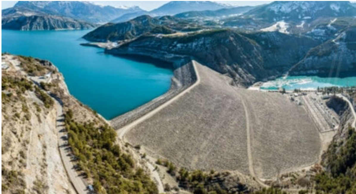
Le barrage terre (ou barrage poids) de Serre-Ponçon
