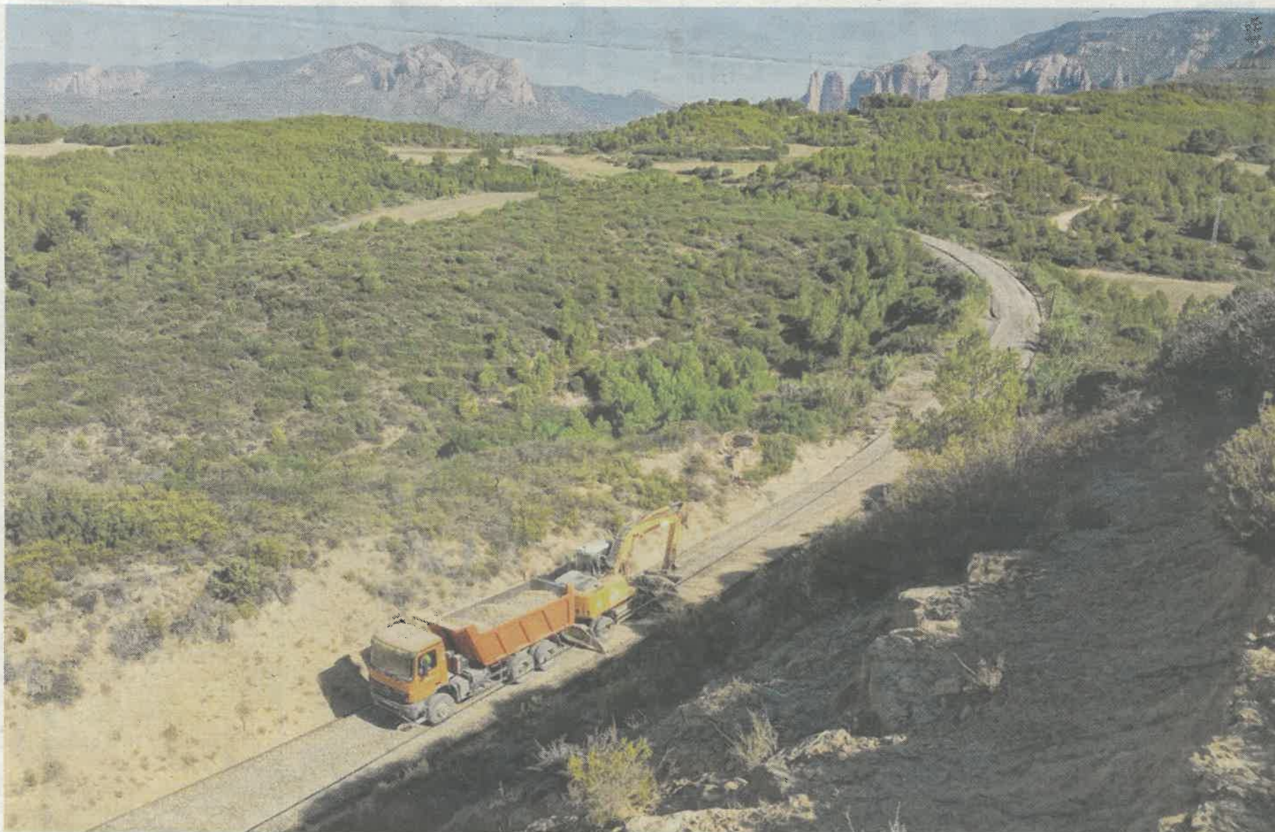
Un camion sur le chantier de rénovation de la ligne ferroviaire entre Ayerbe et Caldearenas. © DIARIO DEL ALTO ARAGON
