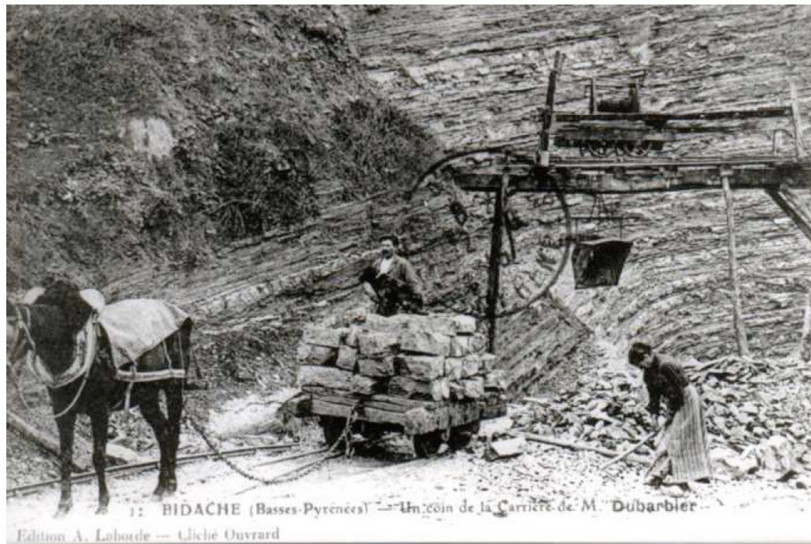
Extraction et transport des pierres de Bidache dans la carrière Dubarbier
