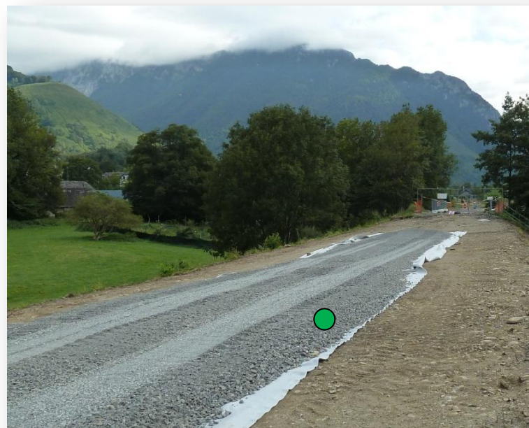
Pose de la sous couche Calcaire gris
