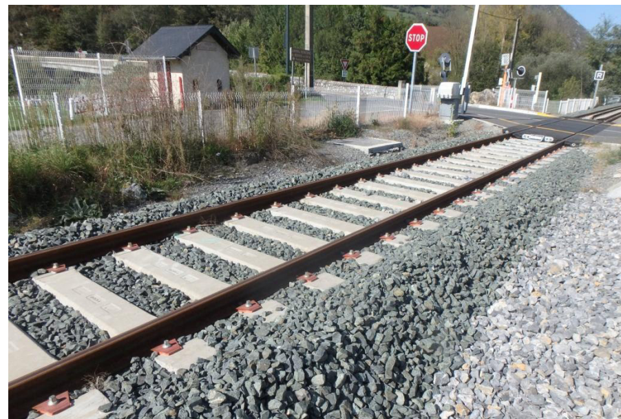
La voie terminée: balast en ophites (●) sous couche en calcaire (●)
