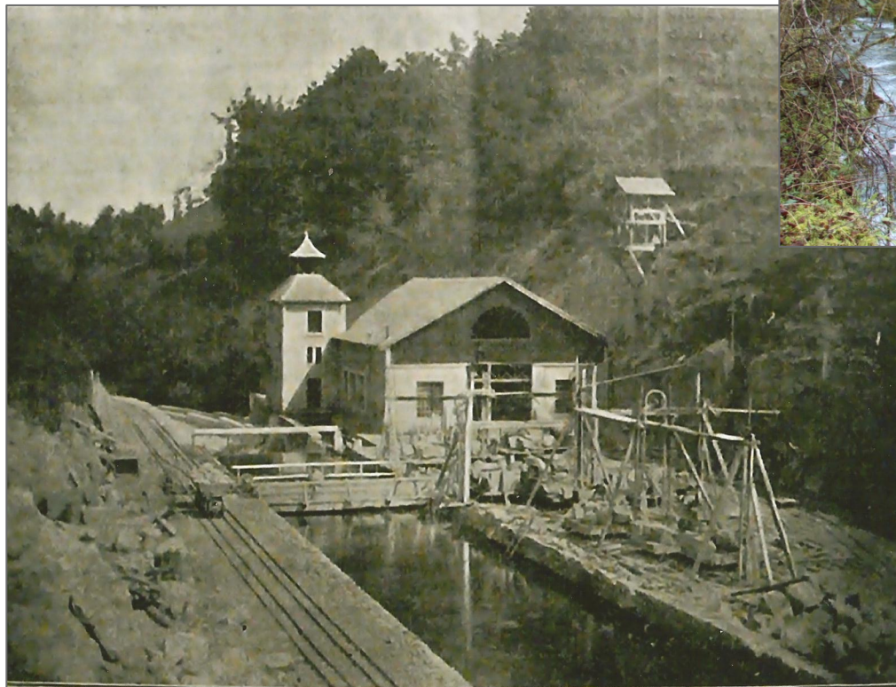
USINE DE LA SOCIÉTÉ A. MICHAUD ET C e AUX CARRIÈRES DES BARONNIES Installation d'ensemble des fils hélicoïdaux.
