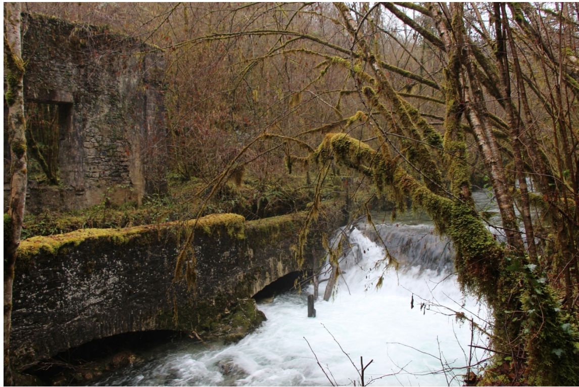
Vestiges des systèmes hydrauliques
